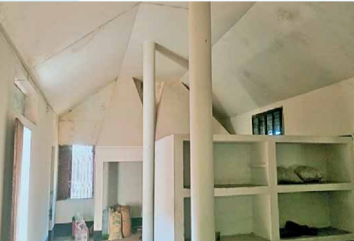
Die sanierte Küche im Inneren.
