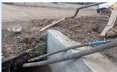
Neue Wasserleitungen in Kotagiri.
