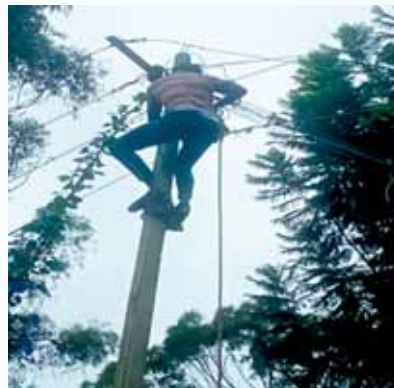
Reparatur der Stromleitung in Kotagiri
