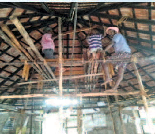
Dachreparatur in der Tagesstätte Azhagiapandipuram
