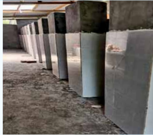
Die neuen Toiletten in Kallupatti werden gefließt
