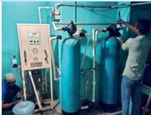
Wartung der Wasseranlage in Hindmotor
