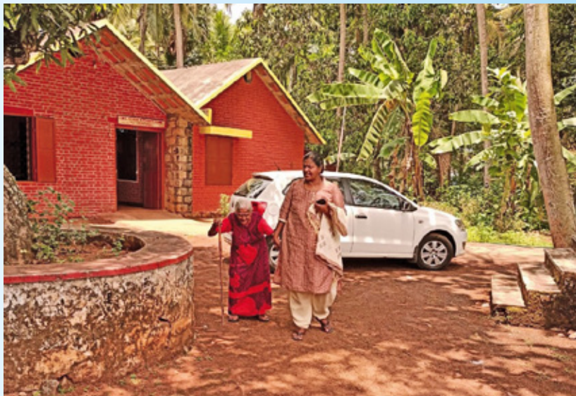
Auf dem Gebäude soll die Solaranlage gebaut werden.
