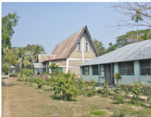
Das Jungenheim in Haluaghat vor der Beschädigung.
